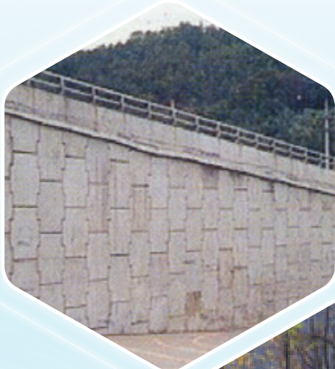
경춘국도 입체교차로 Gyeongchung National Road Interchange
